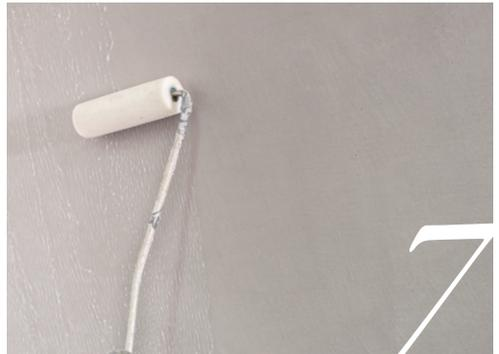
Wir empfehlen die Fläche innerhalb von 6-24 Std. ein zweites Mal zu versiegeln, Nassbereiche und beanspruchte Flächen sind zwingend ein zweites Mal zu versiegeln. Die dauerelastische Verfugung von Sanitärobjekten / Wand-Bodenanschlüssen sowie um Duschrinnen & Bodenabläufen sollte frühestens 3 Tage nach der Versiegelung und ausschließlich mit neutralem Silikon (Natursteinsilikon) erfolgen.
