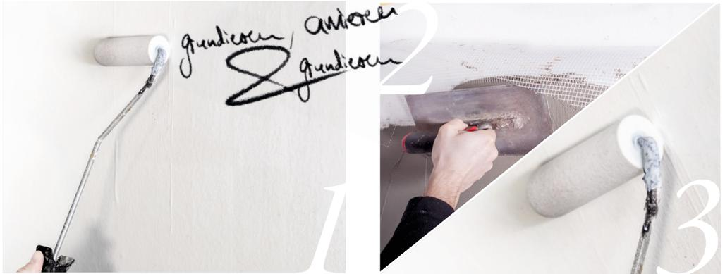
Caramelo Komponente A (Pulver) je 1Kg mit Komponente B (Resin) 250g **abwiegen\***, anmischen und in 2 Schichten (à 1 mm) mit einem französischen Spachtel möglichst ansatzfrei auf die zuvor grundierte Fläche auftragen. Angemischtes Material ist innerhalb von 45min zu verarbeiten.
